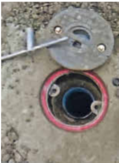
Mit einem Raupenbohrgerät werden Löcher gebohrt, die dann mit einem Schachtdeckel verschlossen werden.
