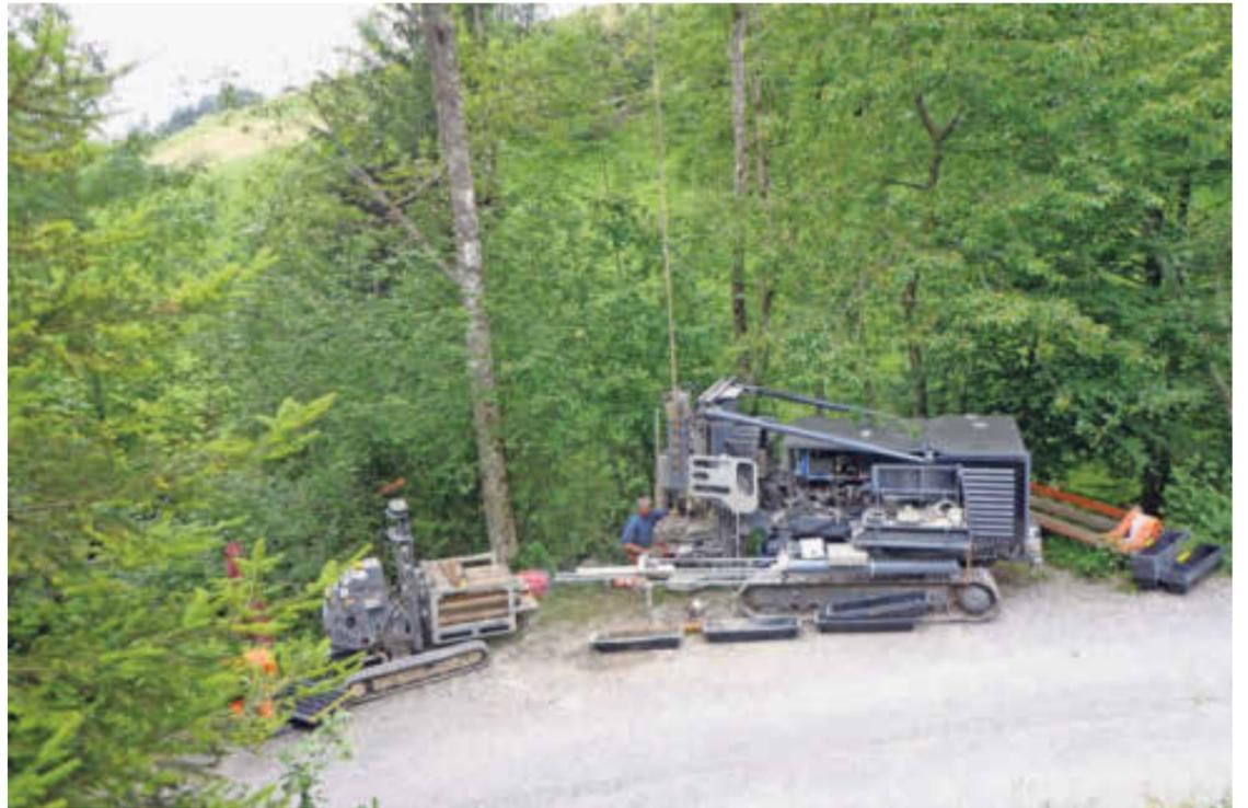
Das Bild zeigt die im Einsatz stehende Bohrmaschine für die Sondierungsarbeiten für den künftigen Umfahrungstunnel in Rothenthurm. Es wird bis zu 40 Meter tief gebohrt. Bild: Martin Schelbert
